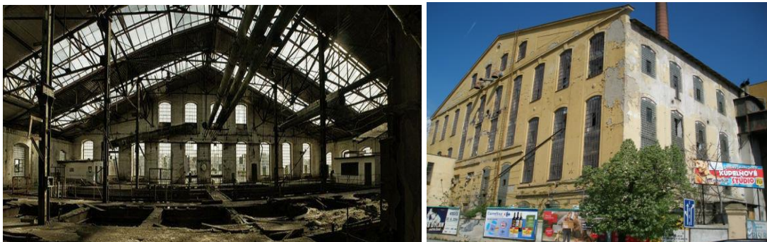
Obr. 4 budova výrobnéj haly [28] a budova cukrovaru - technická pamiatka
